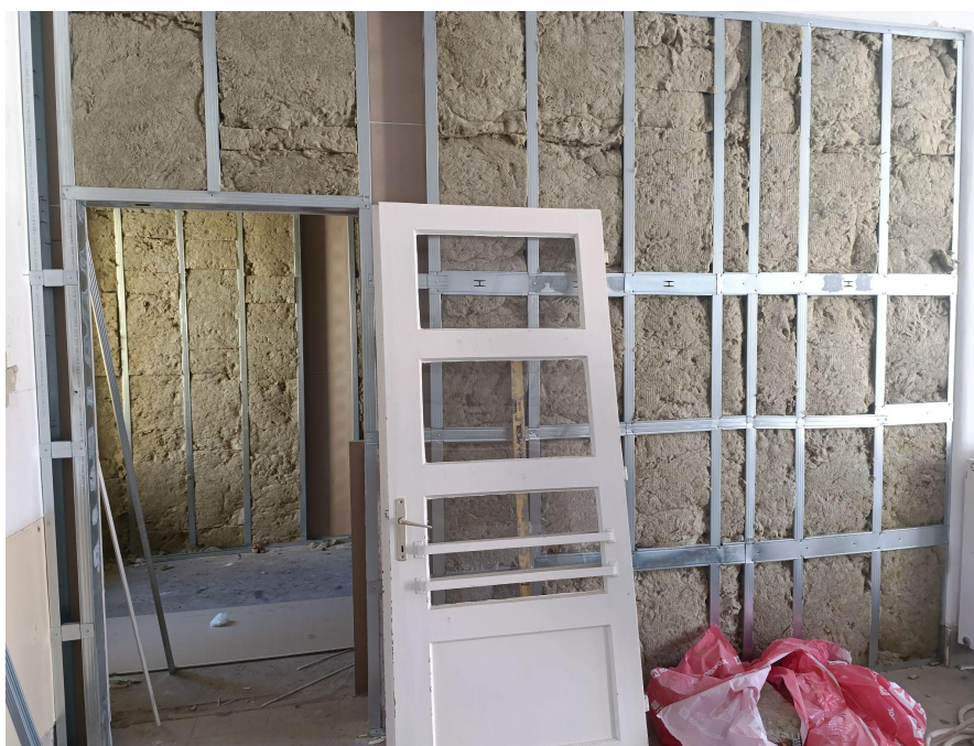
Új falak építése
